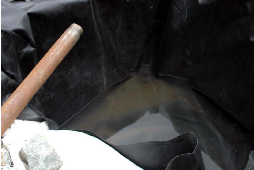
FOTO 9: Pozo de lodo vacio
